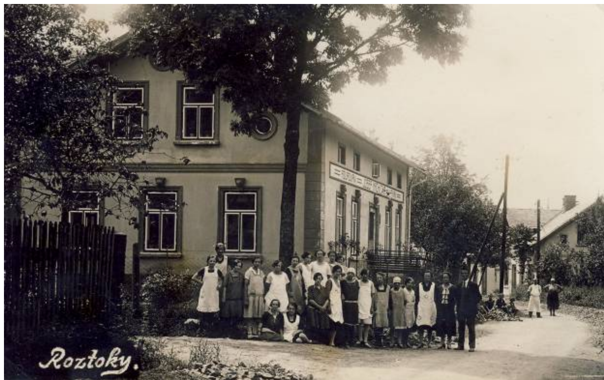
Foto 1935, před rekonstrukcí silnice
