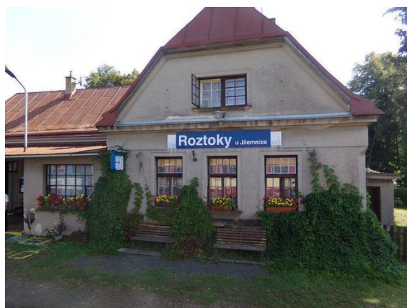
Obrázek č. 6: Budova vlakového nádraží v Roztokách u Jilemnice Zdroj: Mapy.cz
